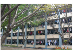
◆ 运动医学楼 1958年建，建筑面积2032㎡，4层，2003年装修，2006年新改建教学综合楼
